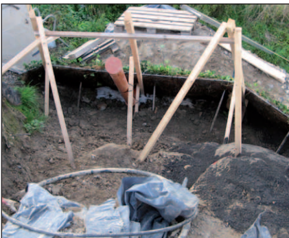
Ausbildung der Ecke durch vorgefertigte Passelemente und Zuschnitt vor Ort. Nach der Verfüllung wird die nächste Lage Elemente darüber montiert.
