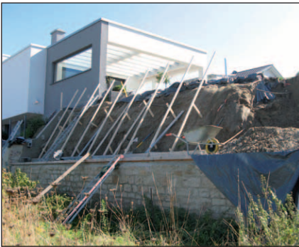
Hilfskonstruktion aus Holz zur planen Ausrichtung der Begrünungselemente. Die Hilfskonstruktion verbleibt im Boden.
