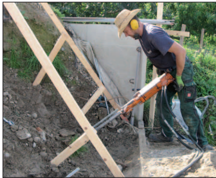
Die Erdanker werden mit dem Hydraulikhammer in den Untergrund getrieben.
