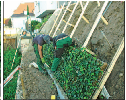
Die Begrünungselemente werden auf die Hilfskonstruktion gelegt, mit den Gewindestangen der Erdanker verschraubt und danach verfüllt.
