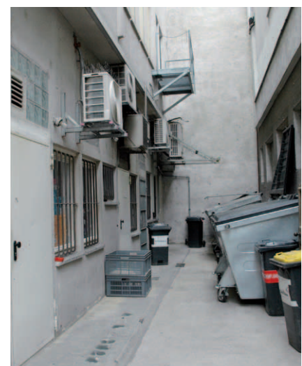
Vorher: Wenig ansprechende Hinterhofatmosphäre
