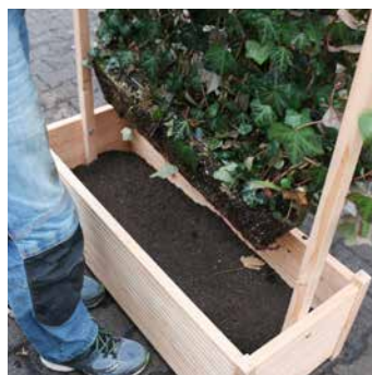
8. Heckenelement ohne Kunststoff-Transportgefäß einstellen
