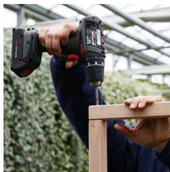
5. Querpfosten oben anschrauben
