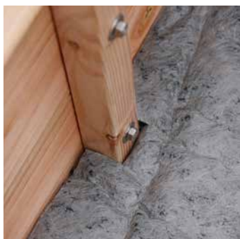
4. Drainagematte rechts und links vom Pfosten einschneiden und einschlagen
