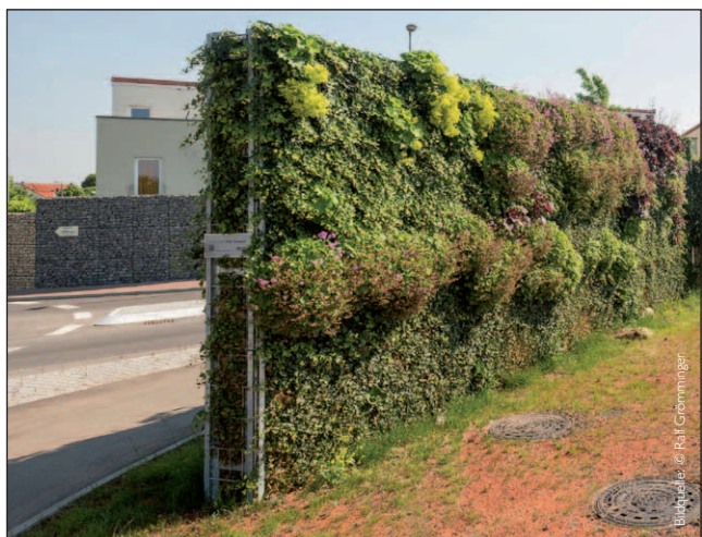
Lärmschutzwand 'Helix® Compacta' Neubaugebiet Sachsenheim: Länge 101 m, Höhe 2,6 m und 3,0 m
