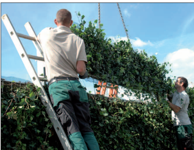
Lärmschutzwand 'Helix® Compacta' Neubaugebiet Sachsenheim: Länge 101 m, Höhe 2,6 m und 3,0 m
