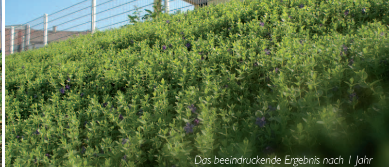
Die Matten sind schnell und einfach verlegt
