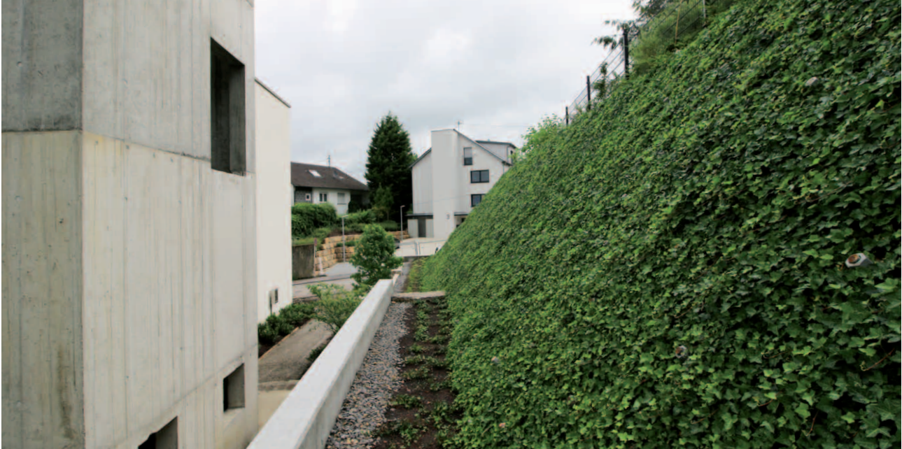
Steilhängsicherung und -begrünung mit Helix® Repens
