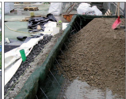
2. 'Helix® Repens DG' Schichtweises Hinterfüllen der Steilhängsicherungs- und Begrünungselemente
