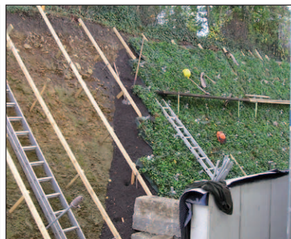
1. 'Helix® Repens' – Montage Begrünungselemente mit hinterfülltem Substrat.
