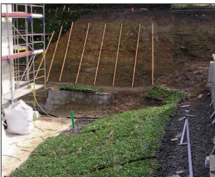
1. 'Helix® Repens' – Unterkonstruktion Auf ein Lattengerüst werden die Begrünungselemente montiert. (vorne: Begrünungselemente Helix® Repens)
