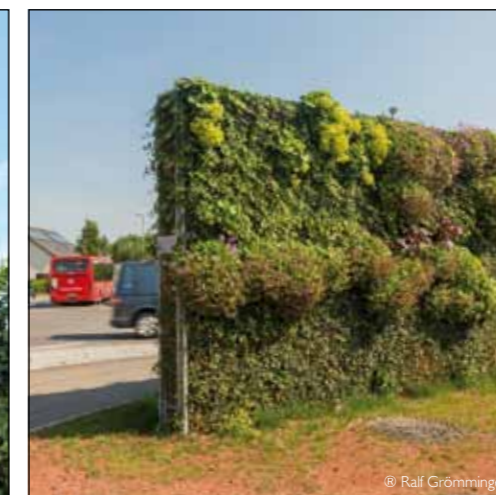
Wegen der geringen Wandstärke gibt es zahlreiche Einsatzmöglichkeiten. Auch Stauden- und Naschbepflanzungen sind möglich. (Lärmschutzwand Sachsenheim)
