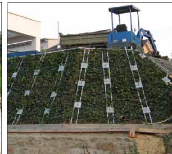
Der Hang ist gesichert und begrünt.
