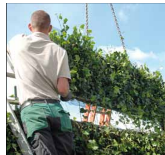
Die vorkultivierten Drahtgittermatten werden mit einem Kern aus Pflanzsubstrat befüllt.
