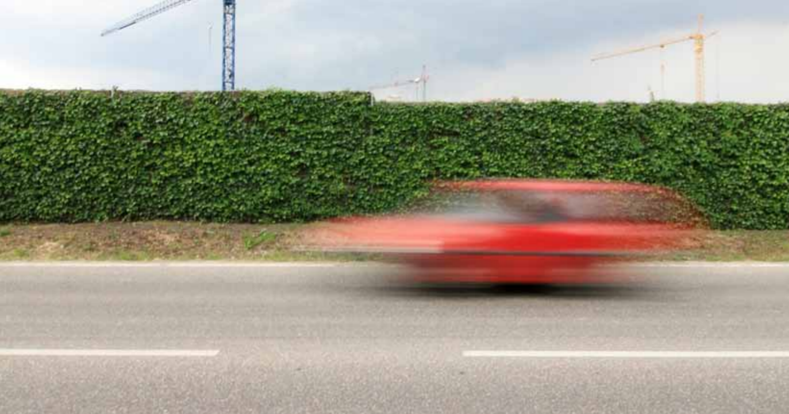
Lärmschutzwand Neubaugebiet Sachsenheim
