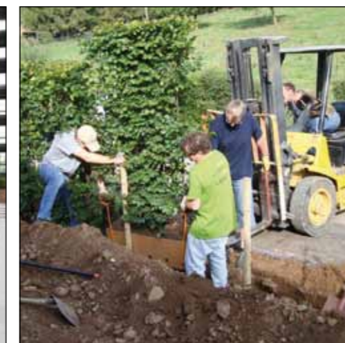
Maschinelles Einbau der Blockware notwendig (Beispiel Fagus sylvatica )
