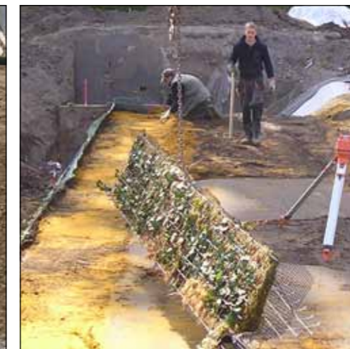
Aufsetzen der nächsten Schicht
