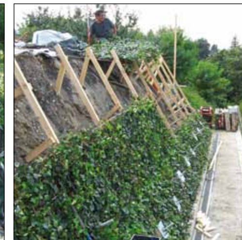
Wandelemente lagenweise montieren und hinterfüllen
