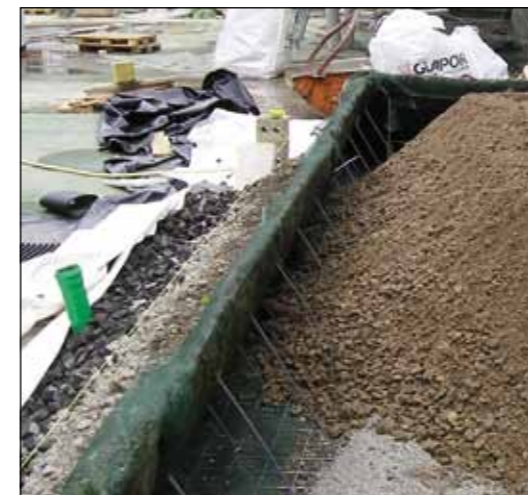
Schichtweises Hinterfüllen der Steilhangsicherungs- und Begrünungselemente
